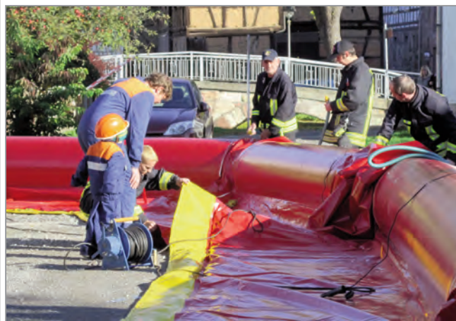
Das flexible Hochwasserschutzsystem ließ sich einfach und schnell aufbauen, die Mitglieder der Feuerwehr Wasungen testeten es im Oktober. Fotos: FF Wasungen
